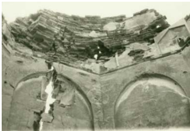
تصویر ۵. نمای داخل برج تخریب شده اشقون بابا در شهرستان بیجار (آ.م.ف. کردستان، ۱۳۶۲).
